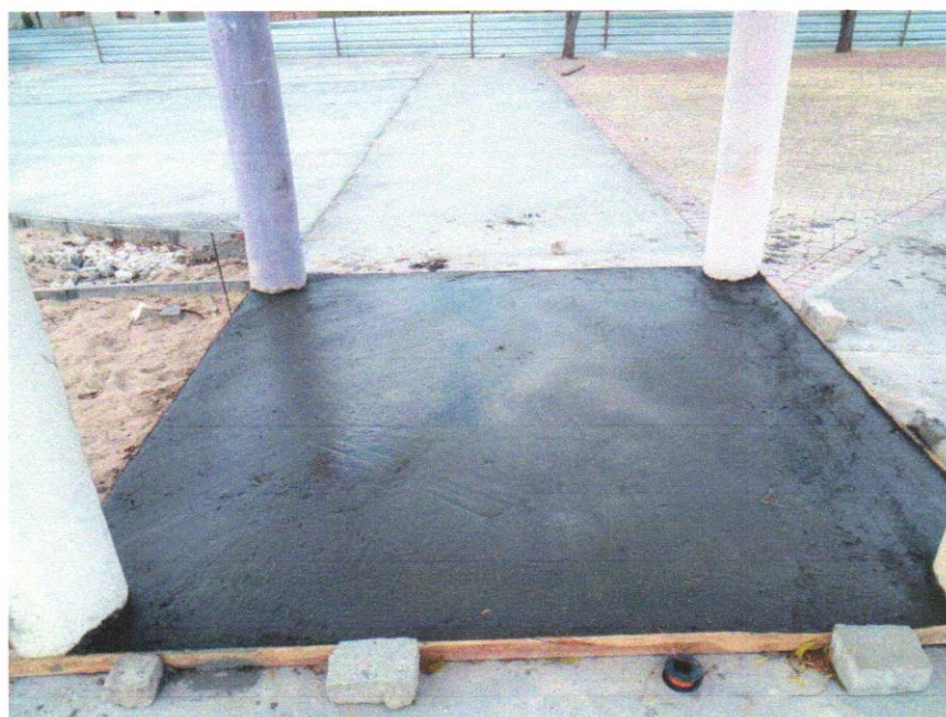
Foto 04 - PAVIMENTAÇÃO EM CONCRETO, COM ESPESSURA DE 7 CM, COM ACABAMENTO FEITO UTILIZANDO ALISADORA DE CONCRETO (HELICOPTERO), INCLUIDO TELA DE AÇO SOLDADA NERVURADA CA60, Q196 (3,11 KG/M2), DIAMETRO DO FIO 5.0 MM, LARGURA = 2,45 M, ESPAÇAMENTO DA MALHA = 10 X 10 CM, JUNTA DE DILATAÇÃO EM PVC A CADA 2,00 M, CONCRETO FCK = 20 MPA
