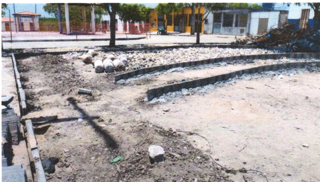
Foto 02 - ASSENTAMENTO DE GUIA (MEIO-FIO) EM TRECHO RETO, CONFECCIONADA EM CONCRETO PRÉ-FABRICADO, DIMENSÕES 100X15X13X20 CM (COMPRIMENTO X BASE INFERIOR X BASE SUPERIOR X ALTURA), PARA URBANIZAÇÃO INTERNA DE EMPREENDIMENTOS. AF_06/2016_P
