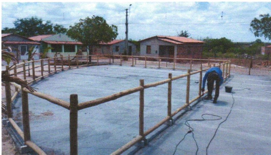
Foto 07 - FORNECIMENTO E MONTAGEM DE CERCA DE PROTEÇÃO EM EUCALIPTO CLOEZIANA TRATADO A BASE DE CCA EM AUTOCLAVE, COM APLICAÇÃO DE STAIN NA COR NATURAL COM DUPLO FILTRO SOLAR, DIÂMETRO DO EUCALIPTO DE 6 A 8 CM, COM ANTI-RACHA NA EXTREMIDADE, FECHAMENTO COM TELA DE ALAMBRADO FIO Nº 12 REVESTIDO DE PVC, MALHA 2.1/2 X 2.1/2", FIXADO COM FIO Nº 14 REVESTIDO EM PVC, MÓDULO MEDINDO 1,50 X 1,00M, PARAFUSOS GALVANIZADOS COM TRAVAMENTO CLICKFIX, CONFORME PROJETO
