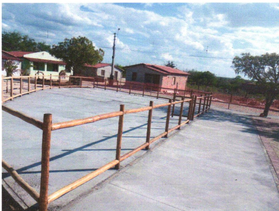
Foto 08 - FORNECIMENTO E MONTAGEM DE CERCA DE PROTEÇÃO EM EUCALIPTO CLOEZIANA TRATADO A BASE DE CCA EM AUTOCLAVE, COM APLICAÇÃO DE STAIN NA COR NATURAL COM DUPLO FILTRO SOLAR, DIÂMETRO DO EUCALIPTO DE 6 A 8 CM, COM ANTI-RACHA NA EXTREMIDADE, FECHAMENTO COM TELA DE ALAMBRADO FIO Nº 12 REVESTIDO DE PVC, MALHA 2.1/2 X 2.1/2", FIXADO COM FIO Nº 14 REVESTIDO EM PVC, MÓDULO MEDINDO 1,50 X 1,00M, PARAFUSOS GALVANIZADOS COM TRAVAMENTO CLICKFIX, CONFORME PROJETO
