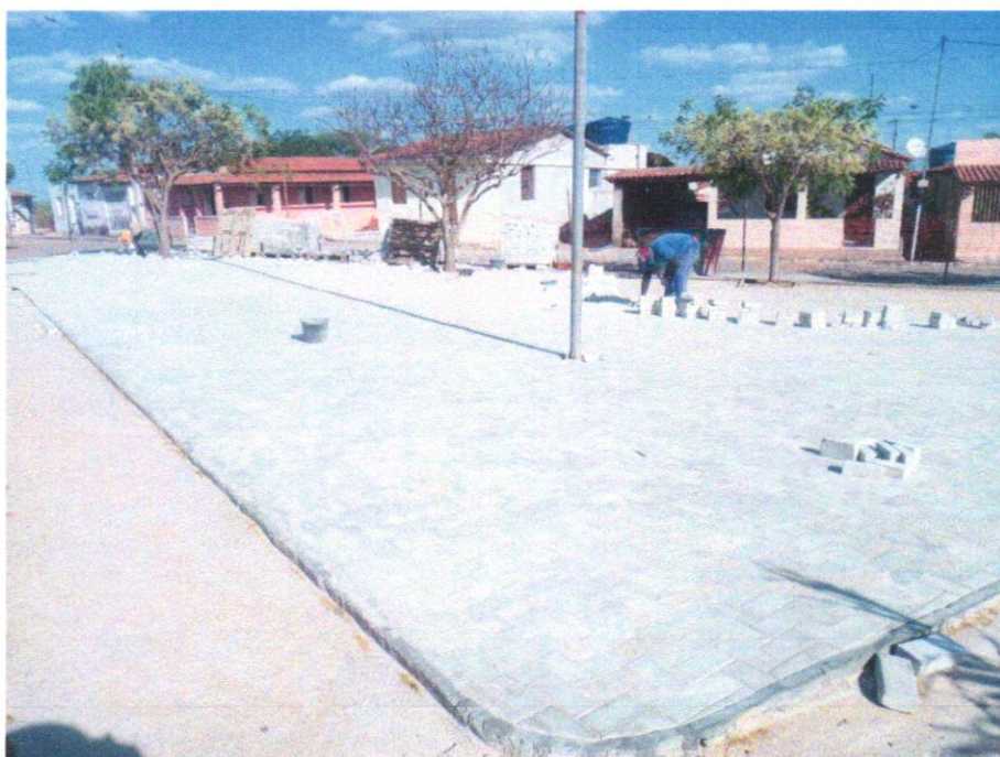
Foto 06 - Pavimentação em bloco de concreto vibroprensado, intertravado, cor natural, 10x20cm, e=6cm, 46un/m 2 , NBR9781, Fck(min)=35MPa, sob coxim areia grossa compactada c/ placa vibratória, e(comp.)=6cm, rejuntado c/areia fina.
