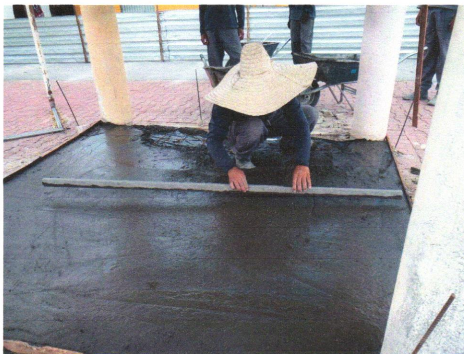
Foto 03- PAVIMENTAÇÃO EM CONCRETO, COM ESPESSURA DE 7 CM, COM ACABAMENTO FEITO UTILIZANDO ALISADORA DE CONCRETO (HELICOPTERO), INCLUIDO TELA DE AÇO SOLDADA NERVURADA CA60, Q196 (3,11 KG/M2), DIAMETRO DO FIO 5.0 MM, LARGURA = 2,45 M, ESPAÇAMENTO DA MALHA = 10 X 10 CM, JUNTA DE DILATAÇÃO EM PVC A CADA 2,00 M, CONCRETO FCK = 20 MPA
